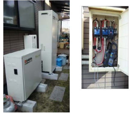
図1 津山市の家庭で利用されている固体高分子型燃料電池システムの一例
