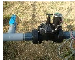
図4 電磁弁
