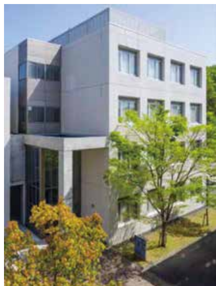
専攻科棟 平成9年4月1日専攻科設置
