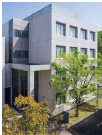
専攻科棟 平成9年4月1日専攻科設置
