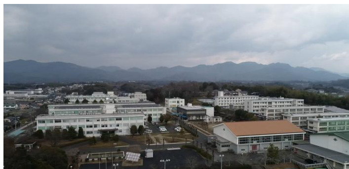
ドローンで空撮した津山高専
